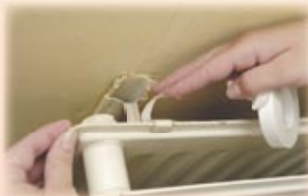
7. Maak een deel van de beschermlaag los en vouw deze om.
