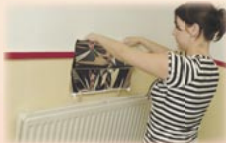
8. Verzwaar de onderkant van de folie met enkele wasknijpers en laat de folie achter de radiator zakken.
