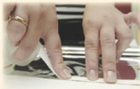
3. Plak het meegeleverde dubbelzijdig tape op de rand van de HR-radiatorfolie.
