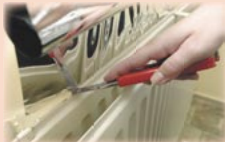
11. Snij met een scherp mes de folie af en doe vervolgens de volgende baan.
