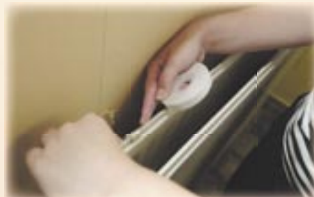
6. Plak het dubbelzijdig tape op de bovenrand van de radiator.
