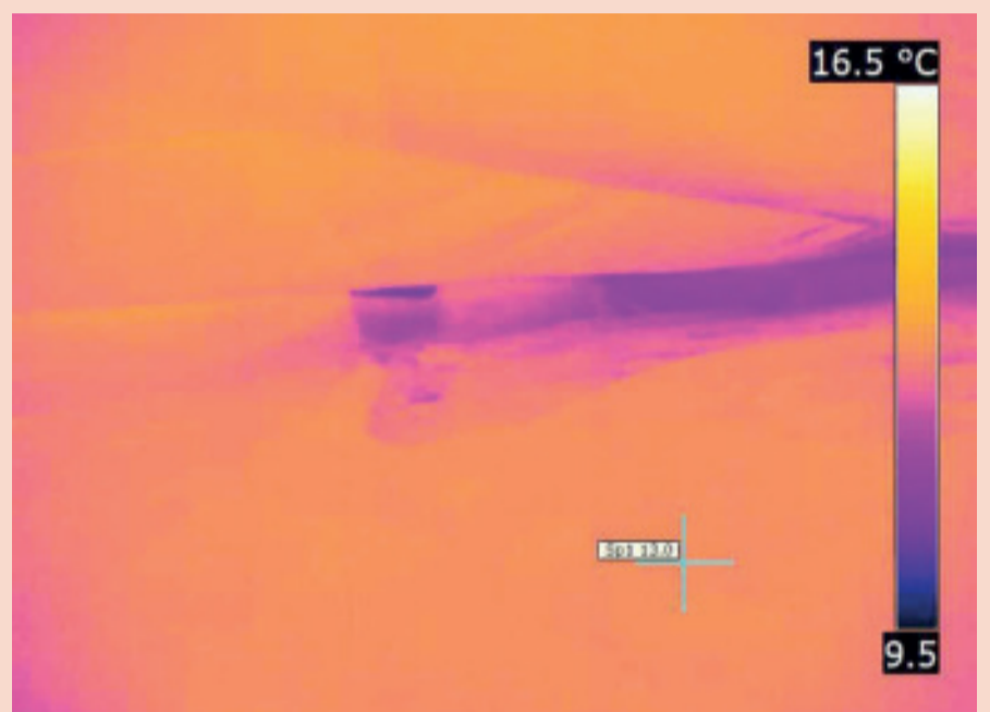
Dezelfde kruipruimte nadat TONZON Thermoskussens zijn aangebracht.
