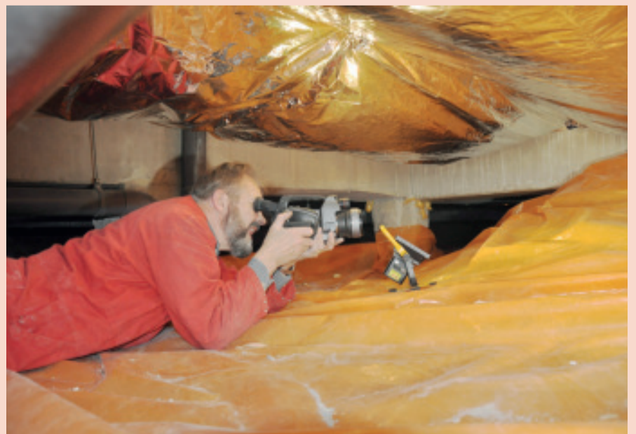
Ton Willemsen maakt warmtebeeldopnames onder de vloer.
